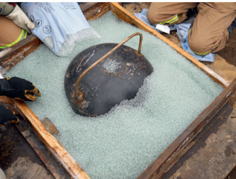
Abb. 4 – Auffüllung des Ringraums mit Glaskugeln. Die 18 Zoll breite, in der Bildmitte zu sehende „Bullnose“ sowie der Holzrahmen wurden eigens für die Aufnahme der Glaskugeln konzipiert.
