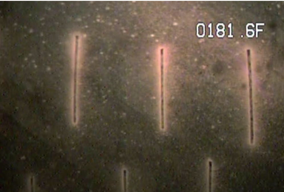
Abb. 3 – Aufnahme aus der Videountersuchung nach der Sanierung. Durch die gefräzten Schlitze ist deutlich die regelmäßige Verteilung der Glaskugeln zu erkennen.
